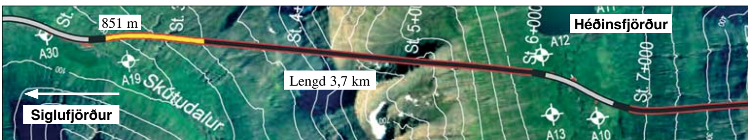
Staða framkvæmda við Héðinsfjarðargöng 5. febrúar 2007. Búið er að sprengja 841 m í Siglufirði og 539 m í Ólafsfirði.
